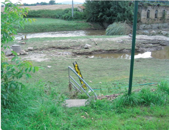
Obr. 3.7.2: Zničený profil vodoměrné stanice Budyšín-Weite Bleiche na toku Sprévy v srpnu 2010 – foto: BfUL
